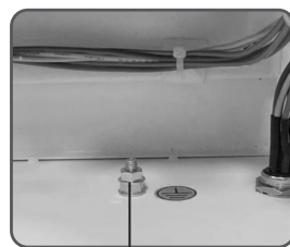
Болт заземлення (підключення PE)
