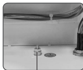
Śruba uziemiająca (PE)
