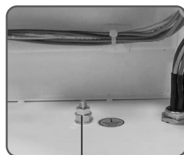
Erdungsschraube (PE)
