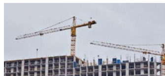
PE ȘANTIERE DE CONSTRUCȚII
