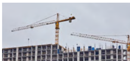
SUR UN CHANTIER DE CONSTRUCTION
