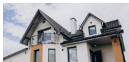
DANS LE SECTEUR DU LOGEMENT
