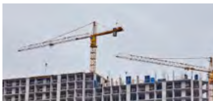
AUF DER BAUSTELLE
