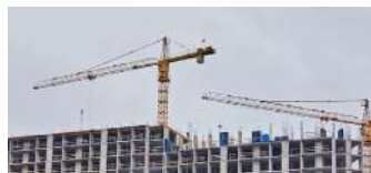
EN LA CONSTRUCCIÓN
