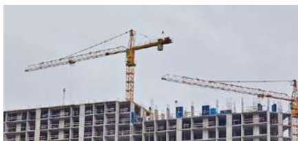
AUF DER BAUSTELLE
