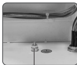
Śruba uziemiająca (PE)
