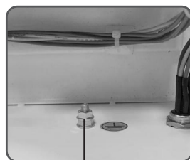
Vis de mise à la terre (PE)
