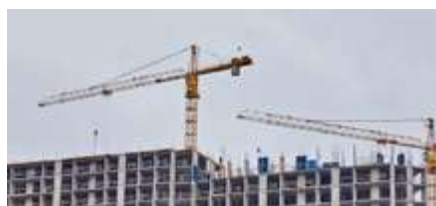
SUR UN CHANTIER DE CONSTRUCTION
