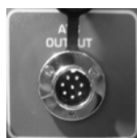
8-pinowe wyjście na generatorze do podłączenia ATS
